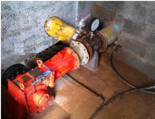
Plate F: Actual installation
